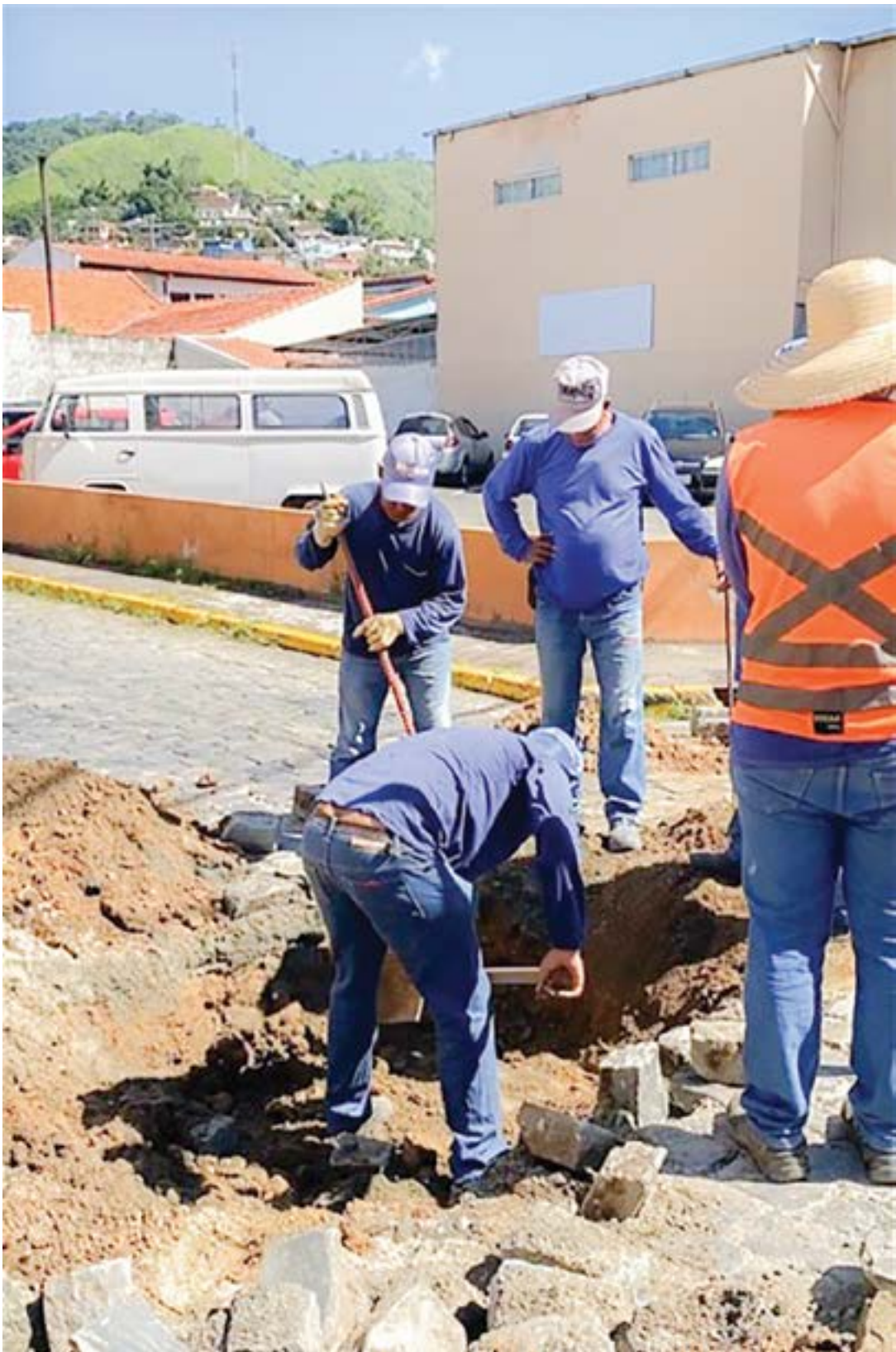
Obra de modernização da infraestrutura sobre saneamento e pavimentação; investimento de R$ 3,8 milhões
