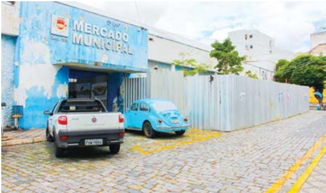
O Mercado Municipal de Guará, que continua sob obras, terá nova licitação após Codesg deixar trabalhos
