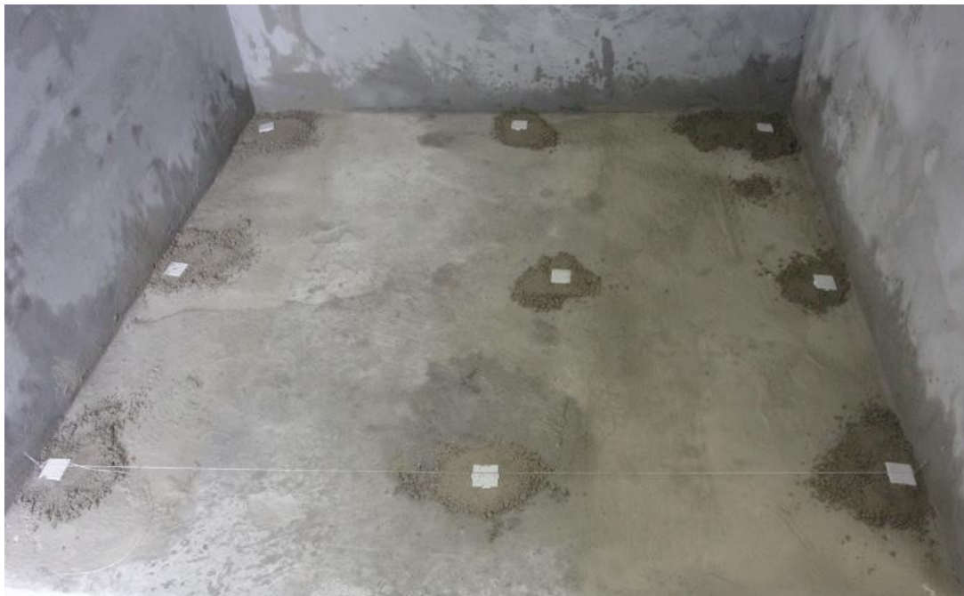
Foto 2: Execução de taliscas
